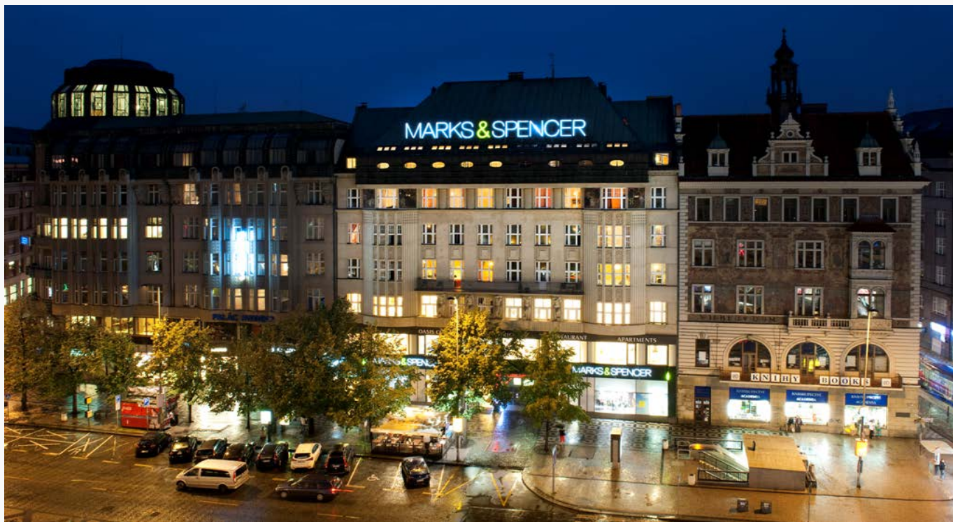
Budova Melantrich, Praha
